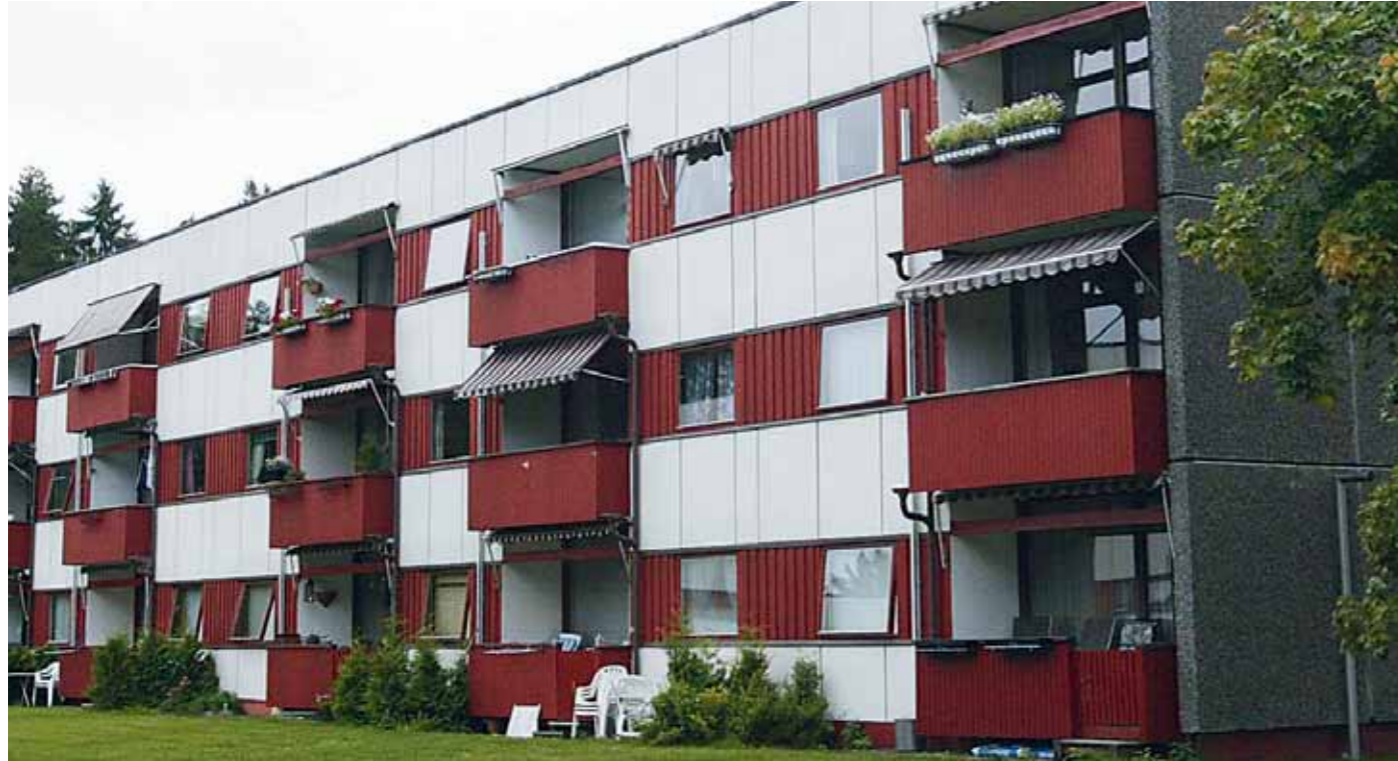
Myhrerenga før oppgradering. Foto: Arve Brekklus/Byggeindustrien
