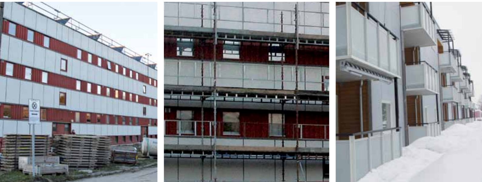
Foto: SINTEF Byggforsk
