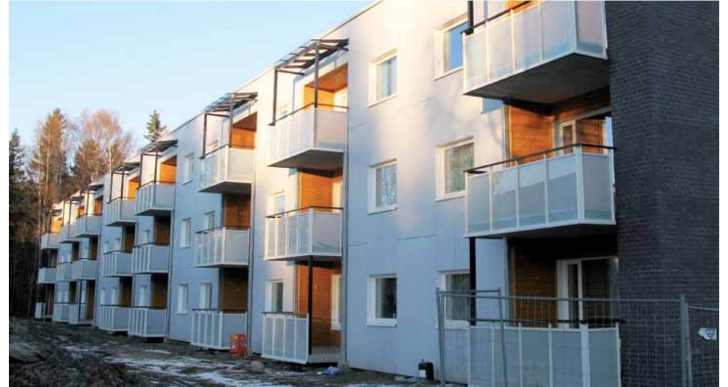
Myhrerenga etter oppgradering. Foto: SINTEF Byggforsk
