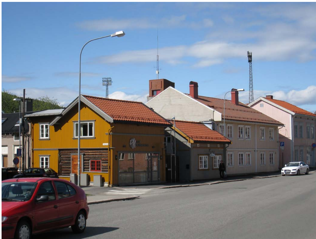
Typiske B- og C-bygg i Tordenskiolds gate.
