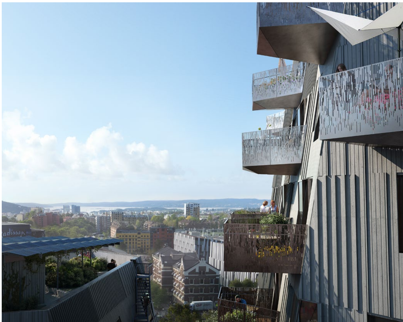
Figur 10: Solcelleanlegg på taket av de to tårnene, utformet som en pergola-løsning for takhagene. III.: Snøhetta/MIR
