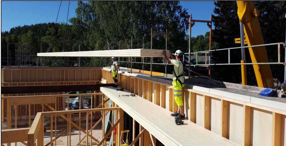
Foto 3. Montering av massivtrelement i flat del av tak (Asker kommune)
