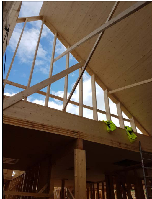
Foto 2. Massivtreelement i takhatt (Asker kommune)
