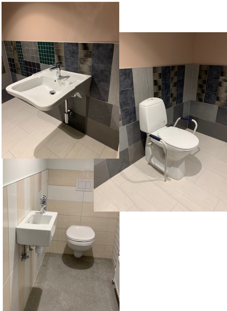
Ombrukt sanitærutstyr ferdig montert.
