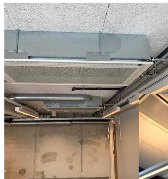
Ombrukte kjøleabfler ferdig montert (ovenfor)
