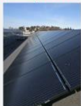
nd installasjon CC Vest
