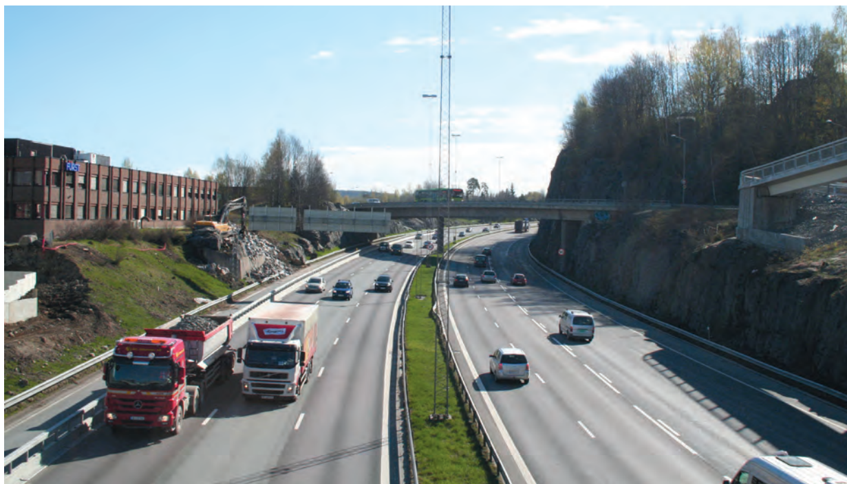
E6 SETT MOT ØST FRA BRO VED MOSKEEN, NÆRINGSBYGG I NØR TIL VENSTRE Foto: PBE 2010
