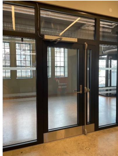
Ombruksdører med ombrukt dørautomatikk på plass
