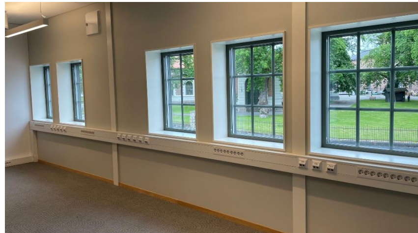
EL-kanaler re-montert i Skur 38 med nye stikk og nettuttak
