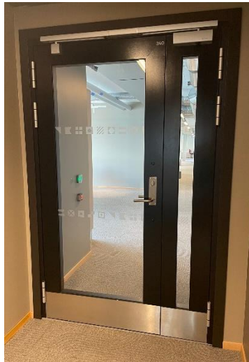
Ombruksdører med ombrukt dørautomatikk på plass
