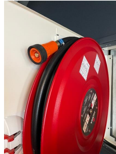
Brannskapene fikk nye låser og skapdører ble malt, mens slangene fikk nye strålerør. Alle skap ble kontrollert og re-sertifisert
