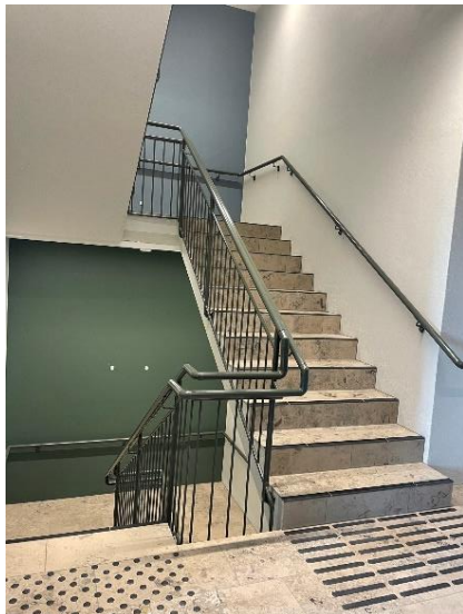
Trapperekker ferdig bearbeidet og remontert. Nå ihht. TEK'en, med riktig høyde og stående spiler. Noen deler ombrukt og noe nye deler
