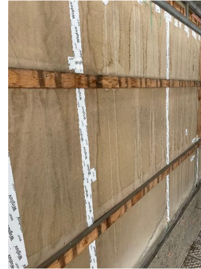
Profilerte lister ble istene ble pusset og malt, vindsperren reparert med tape
