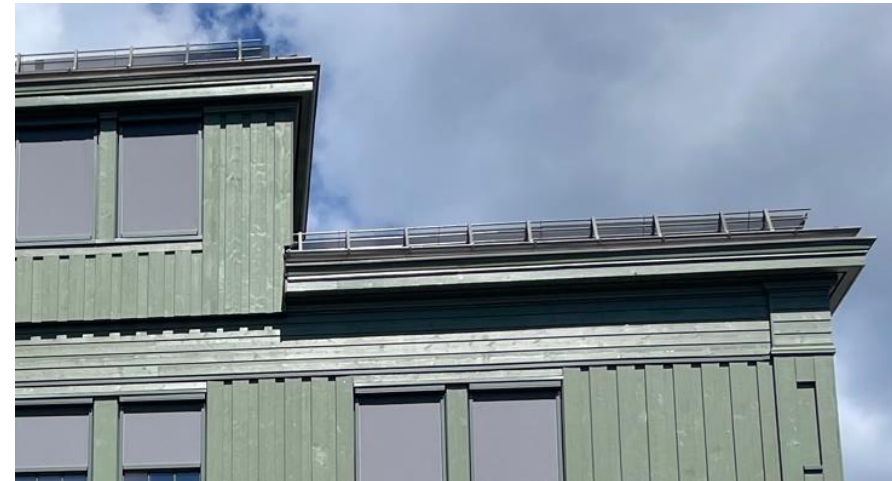
Ny fin fasade med ombrukt vindsperre og lekter og profilerte lister i plan 3 og 4
