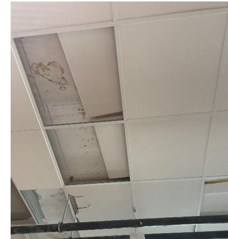
Himlingsplatene ble lagt over nedsenket himling i plan 1, 2 og 3 for bedre lyddemping
