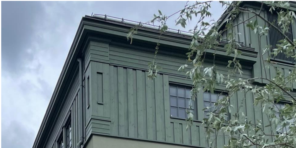
Ny fin fasade med ombrukt vindsperre og lekter og profilerte lister i plan 3 og 4
