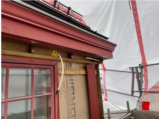
Profilerte trelister, utvendige lekter og vindsperre ble ombrukt
