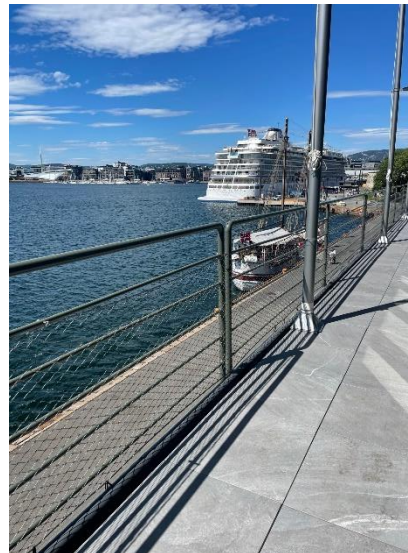
Balkongrekker ferdig remontert, ombrukt i sin helhet med påsveiset ekstra spiler for å oppnå riktig høyde samt påmontert netting
