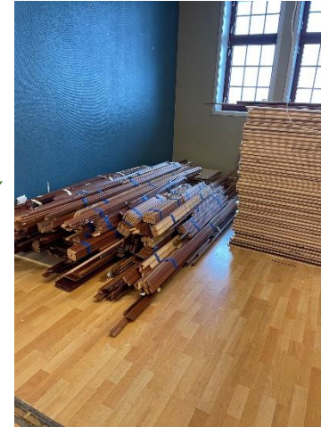
Demontering og lagring
